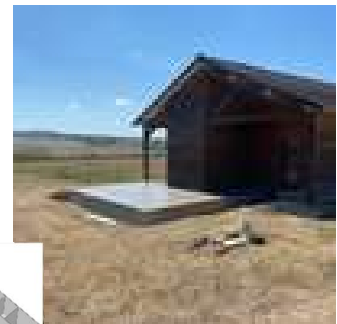
Vide sanitaire, et dalle coulée
